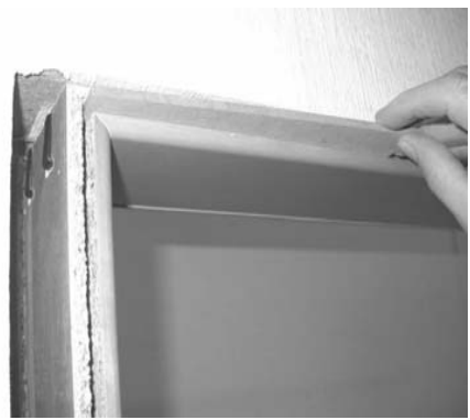
Bild 14: Einlagestreifen einschieben
