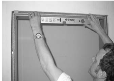
Bild 12: Querteil einrichten
