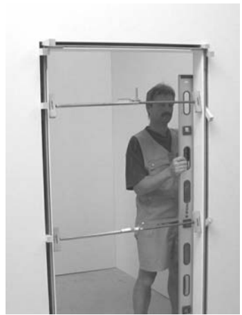
Bild 16: Einrichten der Zarge ins Lot
