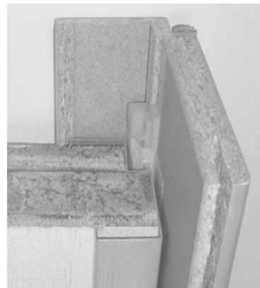
Bild 13a: Platzsituation Stahlzargenummantelung
