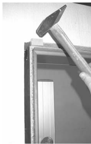
Bild 15: Keile einschlagen
