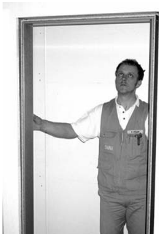
Bild 11: Zarge in die Wandöffnung stellen
