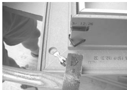
Bild 5: Stahlklammer einschlagen
