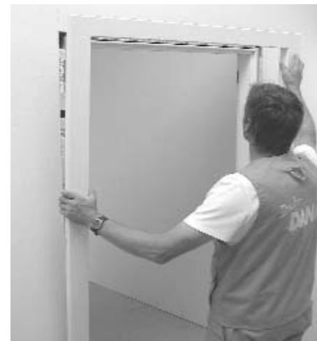
Bild 26: Zierverkleidung einsetzen
